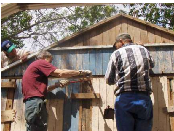
Remontage de la baraque française et réfection de l'escalier du potager. Mickaël Sendra © Association Mémoire de Soye
